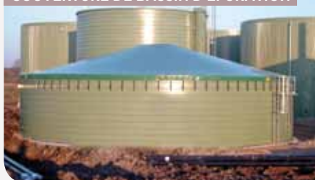
COUVERTURE DE BASSIN D'ÉPURATION
